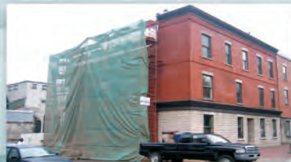
SYNDICAT DES COPROPRIÉTAIRES DU 2030 ST-ANTOINE OUEST Reconstruction des sections des murs de briques avec des ventres de boeuf
