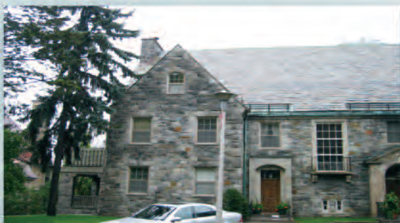
RÉSIDENCE PRIVÉE DU CONSUL DE LA BELGIQUE À MONTRÉAL Réfection professionnelle des joints de mortier, injections des pierres fissurées, imperméabilisation des murs de pierres.
