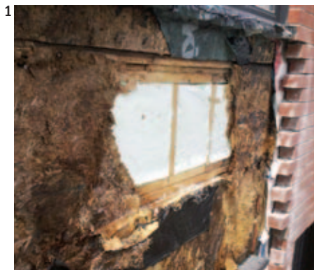
1-2. Dans le mur de cette copropriété, il y avait absence d'espace d'air intérieur. Les taches noires sur ce panneau en bois aggloméré illustrent les moisissures.
