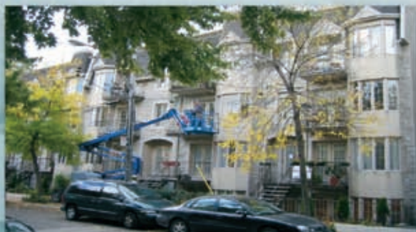
SYNDICAT DE LA COPROPRIÉTÉ 4478 LAVAL Restauration professionnelle et ponctuelle des joints de mortier défectueux
