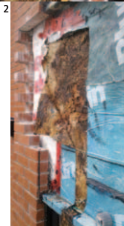
1-2. Dans le mur de cette copropriété, il y avait absence d'espace d'air intérieur. Les taches noires sur ce panneau en bois aggloméré illustrent les moisissures.
