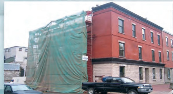
SYNDICAT DES COPROPRIÉTAIRES DU 2030 ST-ANTOINE OUEST Reconstruction des sections des murs de briques avec des ventres de bœuf
